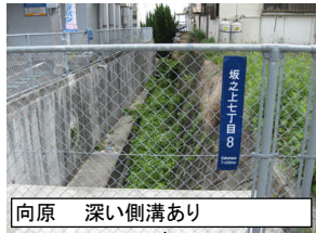
向原 深い側溝あり
