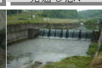
②③ 農業用ダム 稲作期のみ貯水
