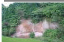
⑤ 崖崩れ 立入禁止
