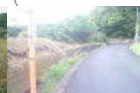
②⑤ 荒毛川上流 柵・ガードレール無し
