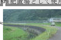
②⑨ 本名川沿い ガードレールなし 落下の恐れがある
