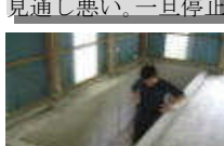
⑧ コンクリート壕 (私有地内) 立入禁止
