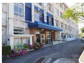
【正面玄関塗装】
