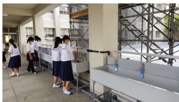
渡り廊下に設置した仮設水道
