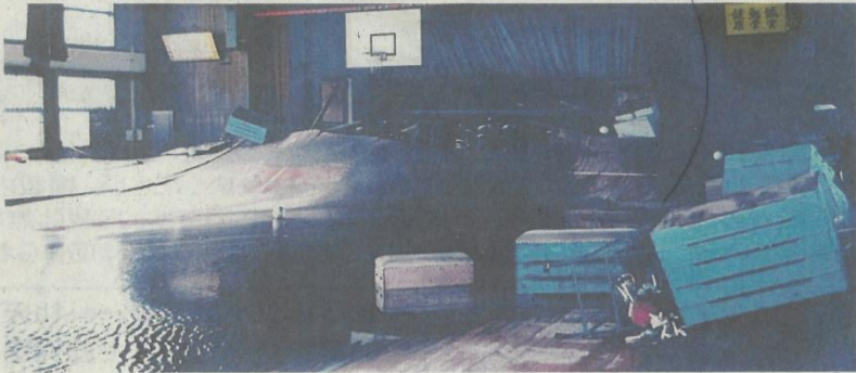
床がめくれ上がった体育館。1993年8月、鹿児島市の河頭中学校（緒方義春さん提供）
