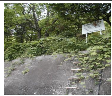
城山の麓の崖 崖崩れの危険あり
