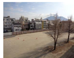
【新校舎の工事が始まりました】
